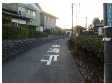
路肩の修繕工事が行われました。
