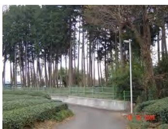
防犯灯が設置されました。
