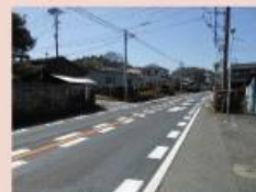
県道の舗装(堀之内)
