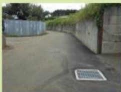
雨水浸透柵の設置(三ヶ島1丁目)
