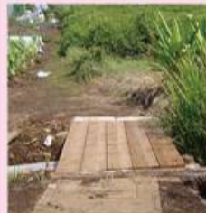
水路の橋の修繕(堀之内)
