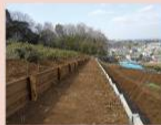
市道の改修(堀之内)
