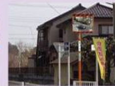
カーブミラーの設置(三ヶ島1丁目)
