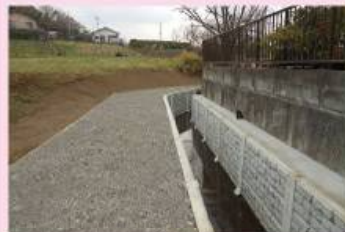
東川上流の改修(三ヶ島1丁目)
