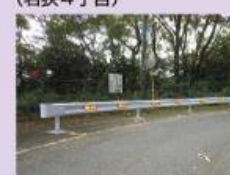
ガードレールの設置(狭山湖周辺)
