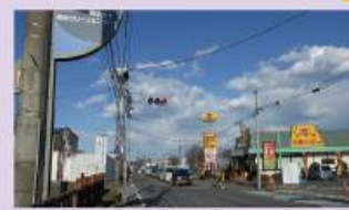
信号機の設置(林1丁目)
