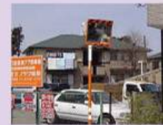
カーブミラーの設置(若狭4丁目)
