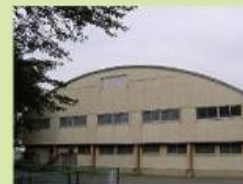
林小体育館の修繕
