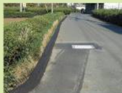
雨水浸透柵の設置(林1丁目)
