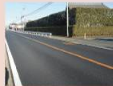
県道の舗装(三ヶ島3丁目)
