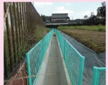
水路の改修(三ヶ島1丁目)
