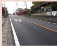
県道の舗装(三ヶ島1丁目)
