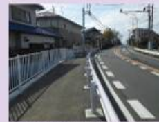
歩道の整備(堀之内)
