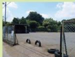
こども広場の水道の修繕(梶谷)
