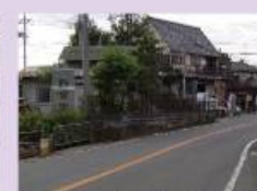
ガードレールの撤去(梶谷)
