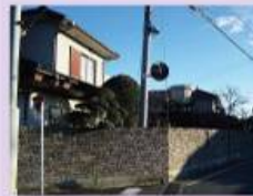
カーブミラーの設置(三ヶ島2丁目)
