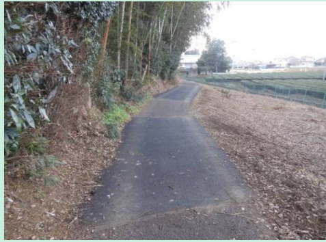
市道の修繕（糞谷）
