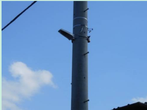
道路照明灯の設置（三ヶ島4丁目）
