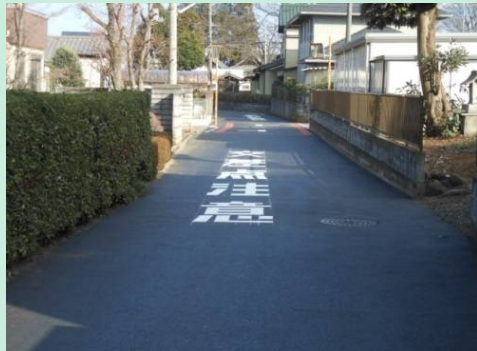
水道管の敷設（三ヶ島3丁目）
