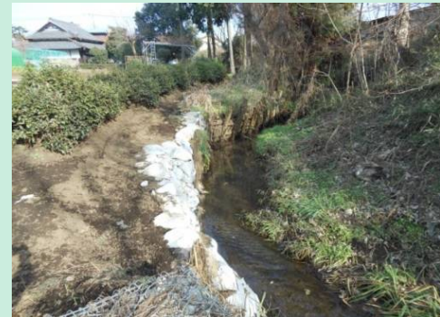
砂川堀の修繕（三ヶ島3丁目）
