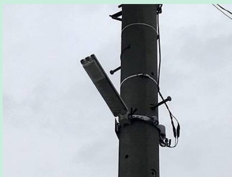
道路照明灯の設置（三ヶ島1丁目）
