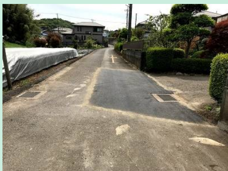
市道の修繕（堀之内）
