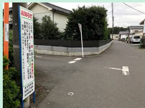
配水管の布設（林1丁目）
