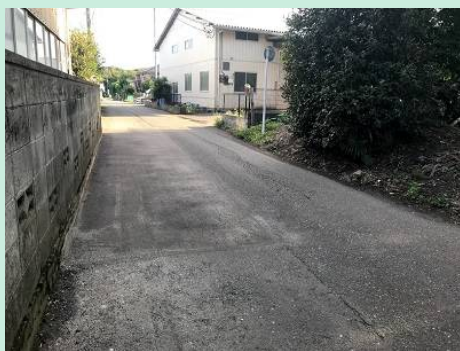
市道の修繕（糞谷）
