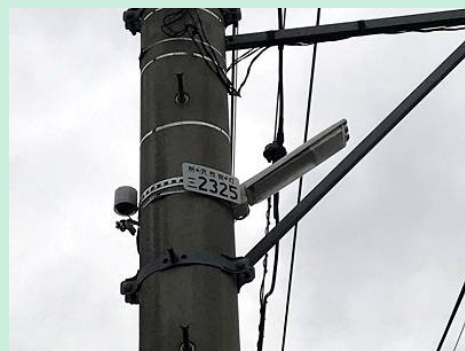
道路照明灯の設置（三ヶ島3丁目）
